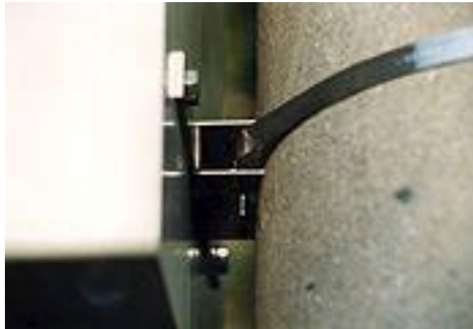
Obr. 11: Ukázka řešení uchycení na sloup.
